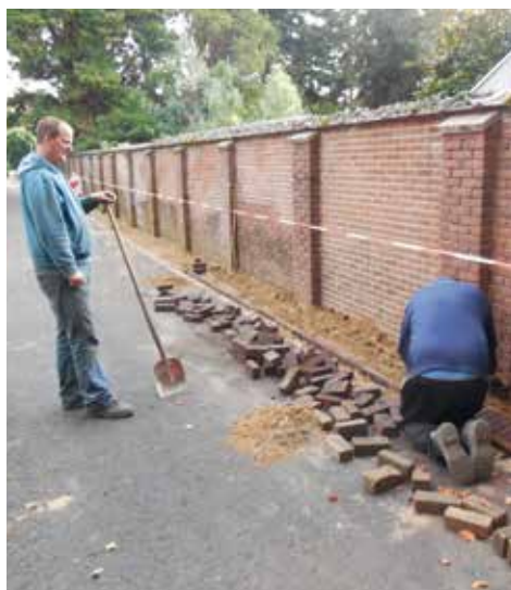
Stratenmakers aan het werk in de Van der Lindenlaan.
